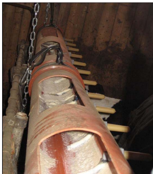
Bild 8: KG-Rohr als Sammeltränke
